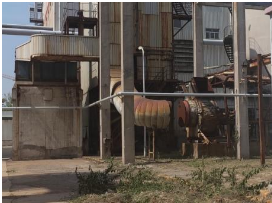
燃煤锅炉烟道物理隔断切除
