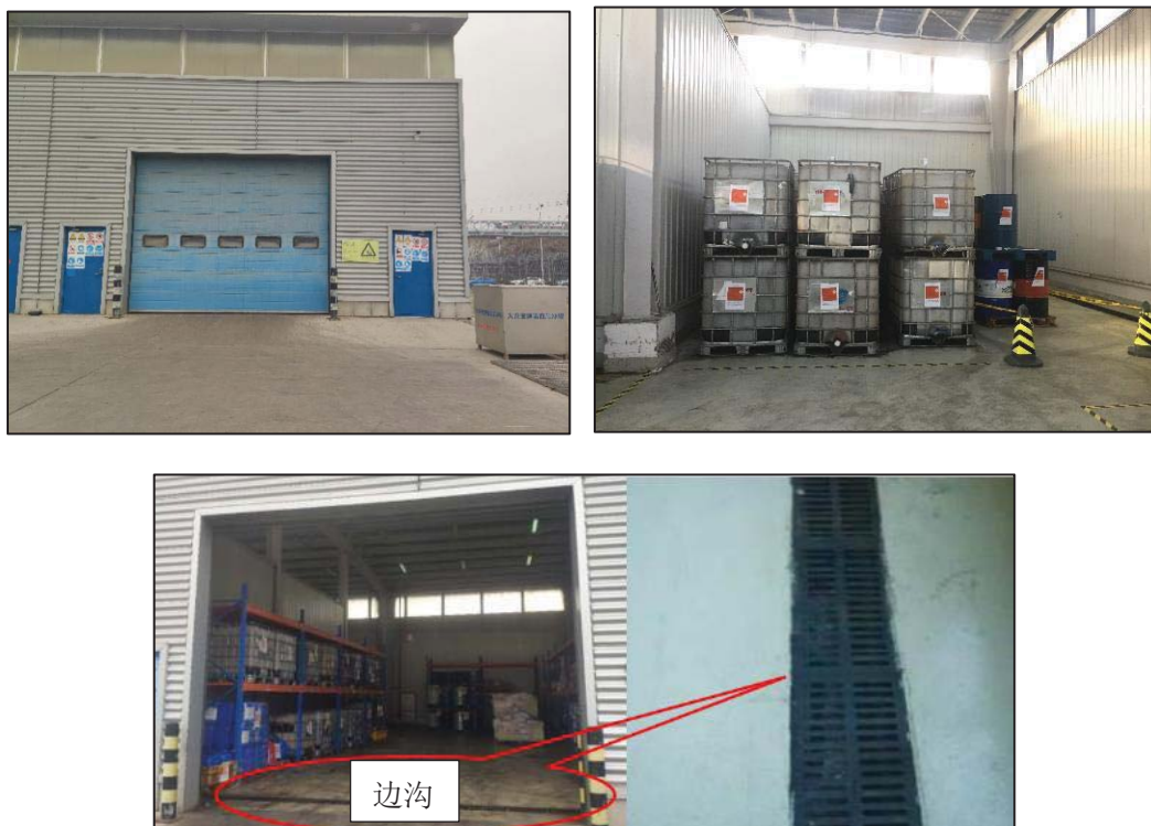
图 2-8 厂区现有危险废物暂存间照片
