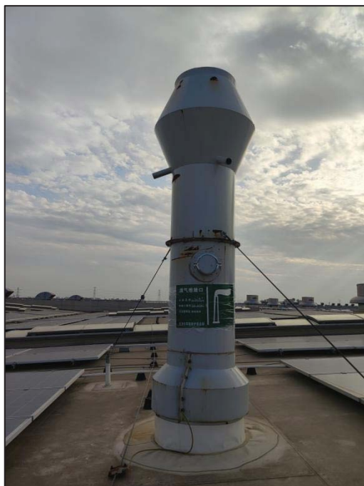
图 2-10 P NPMC-1 示范化建设情况
