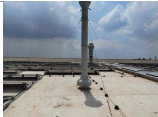
机加工含尘废气排气筒 P310-2
