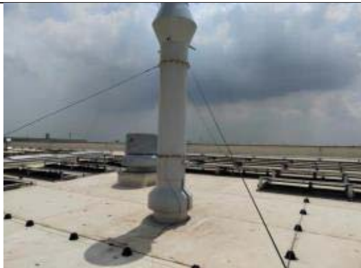
机加工含尘废气排气筒 P310-1
